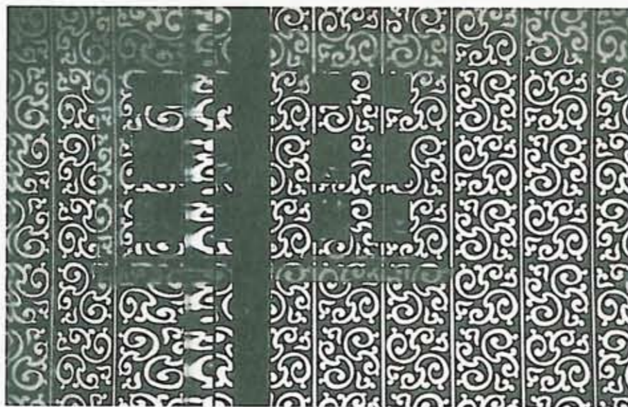
Ranken des siebzehnten Jahrhunderts als Vorlage für Gegenwartsarchitektur: Aluminiumverkleidung einer Wand des neuen Knauf-Museums
